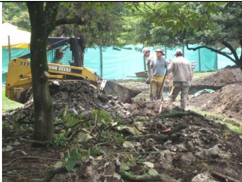
Fotografía No. 011. Proceso de recubrimiento de la mezcla bentonita arcilla, para filtro de infiltración al lago.
