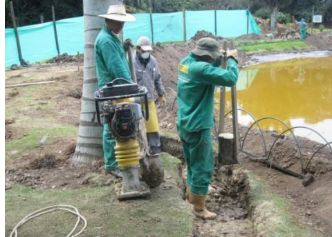
Fotografía No. 08. Apisonado de la mezcla de bentonita y arcilla.
