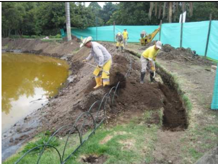
Fotografía No. 03. Excavación para realizar la pantalla perimetral.
