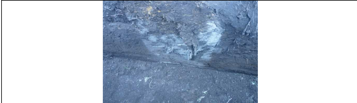
Fotografía No. 035. Detalle de la solución de continuidad de la ya inexistente pantalla en este costado del lago.
