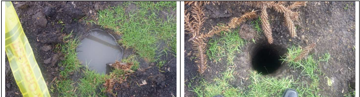
Fotografías Nos. 066 y 67. Tomas a las 2 perforaciones realizadas por la entidad para medir el nivel freático. La primera en el costado suroriental (rebosada en su totalidad) y la segunda en el costado suroccidental del puente que da acceso al aula ambiental.
