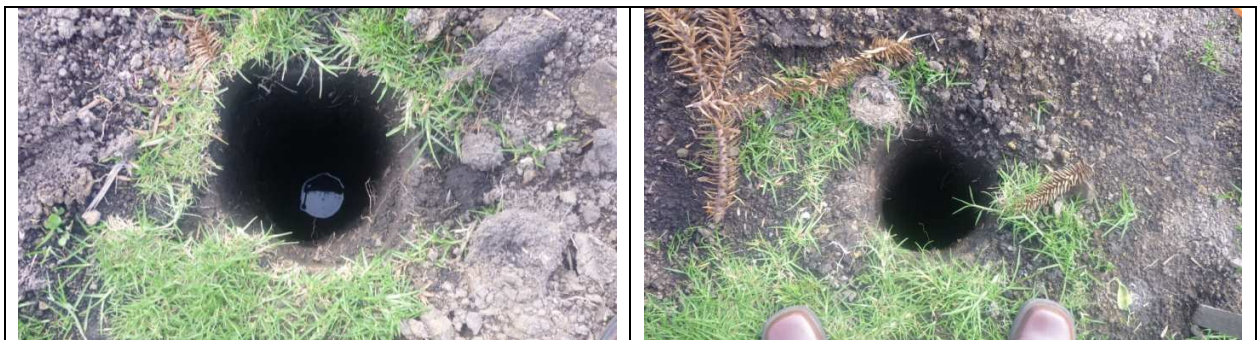
Fotografías Nos. 070 y 71. Tomas en los mismos pozos y en el mismo orden, ellas muestran la baja del nivel freático en el primero, en tanto que en el otro la ausencia de agua ha sido constante.
