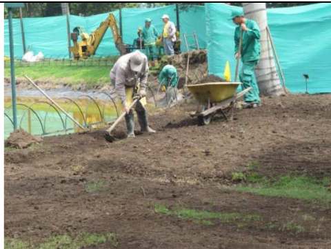
Fotografía No. 012. Proceso de recubrimiento de la mezcla bentonita arcilla, para filtro de infiltración al lago.
