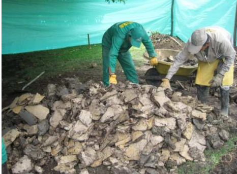
Fotografía No. 07. Selección de la arcilla a mezclar con la bentonita.
