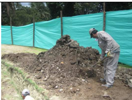
Fotografía No. 05. Excavación para realizar la pantalla perimetral.
