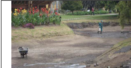
Fotografía No. 020. Levantamiento de lodos del fondo del lago.
