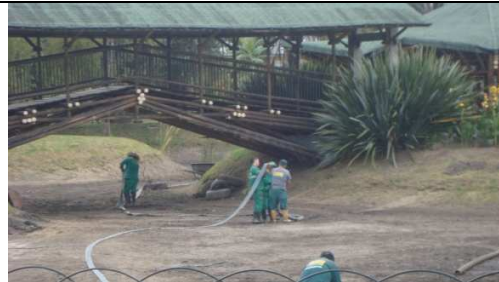
Fotografía No. 021. Trabajos en el fondo del lago cerca al puente de acceso al aula ambiental.
