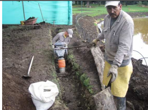
Fotografía No. 010. Apisonado de la mezcla de bentonita y arcilla.
