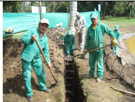
Fotografía No. 04. Excavación para realizar la pantalla perimetral.
