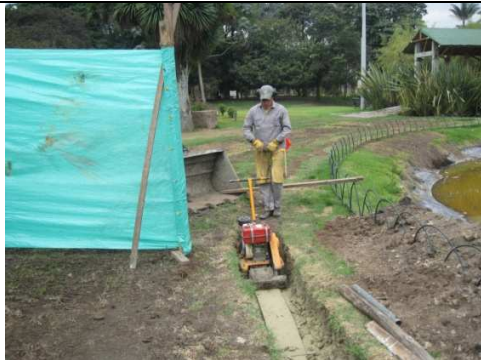
Fotografía No. 09. Apisonado de la mezcla de bentonita y arcilla.
