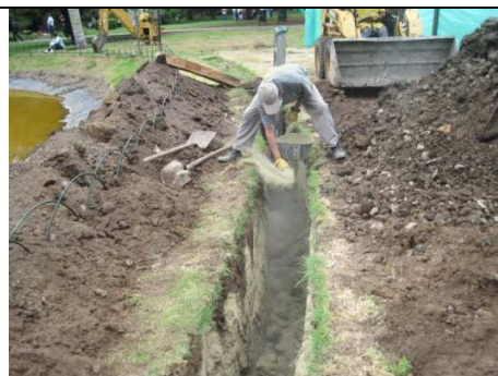
Fotografía No. 06. Aplicación de la Bentonita.
