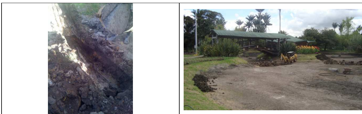
Fotografía No. 038. Fecha 26 de julio de 2011. Hora 10:30 A.M. Excavación de la capa impermeable en el fondo del lago.
