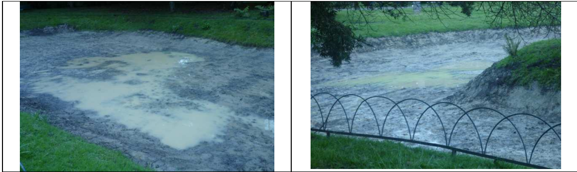
Fotografías Nos. 056 y 057. Formación de charcos de agua por efectos de la lluvia.
